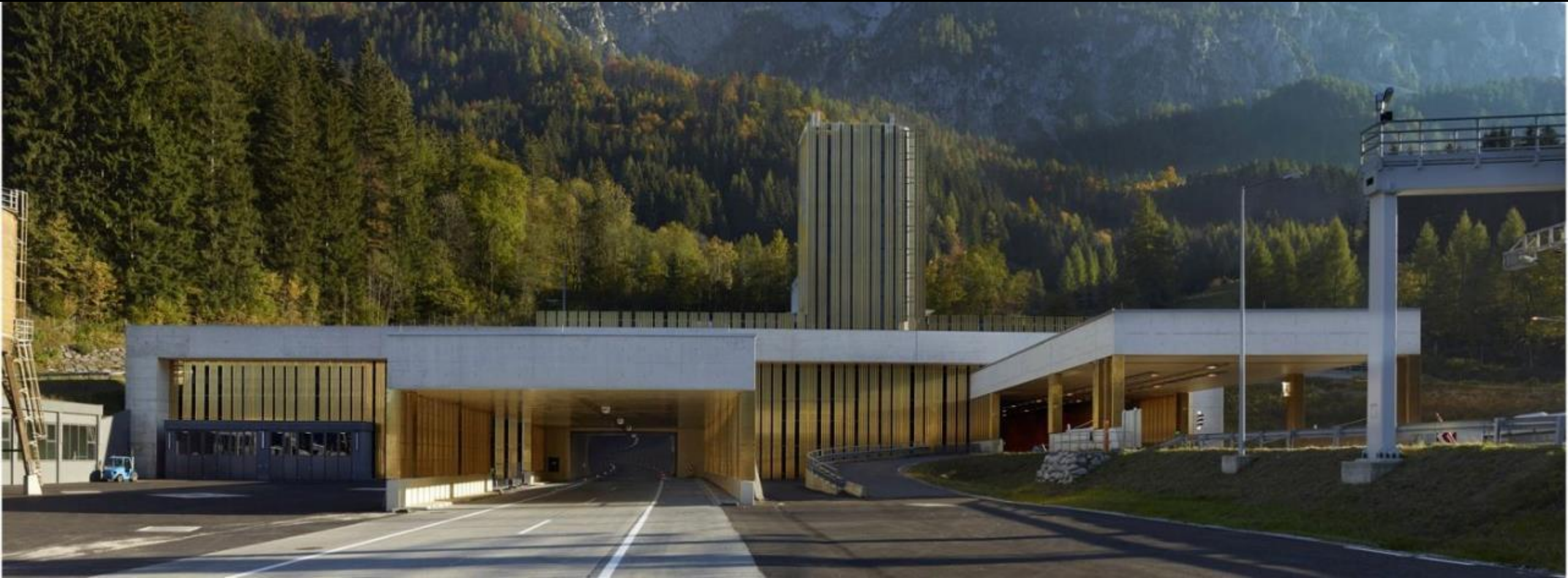
Profiles – Nordic Brass Bosrucktunnel– Ennstal (AT) – Riepl:Riepl
